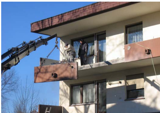
Balkone aus Beton abtragen
