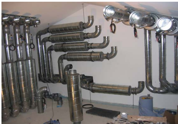
Lüftungszentrale in Bau
