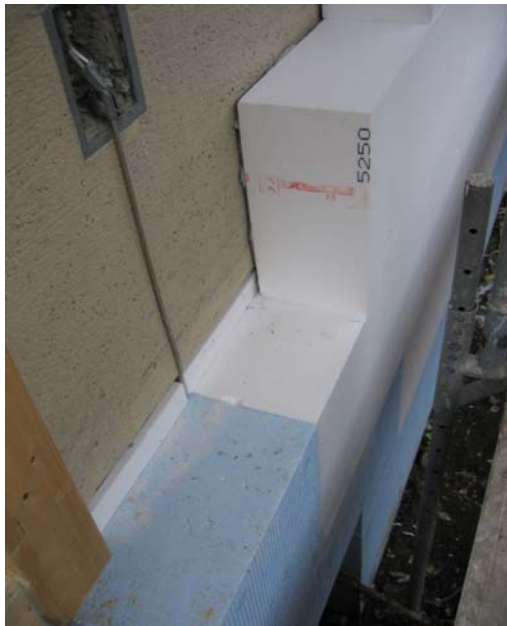
Dämmen der Außenwand mit 25cm EPS
