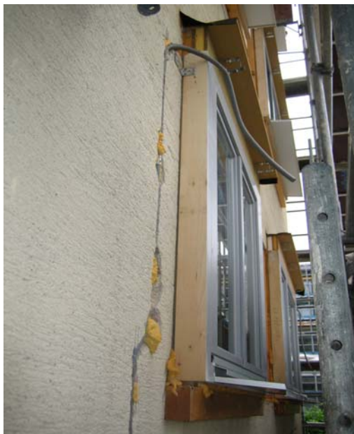
Neues Fenster auf der Vorderkante des Altputzes befestigt, anschließend Fensteranschluss winddicht ausführen und überdämmen
