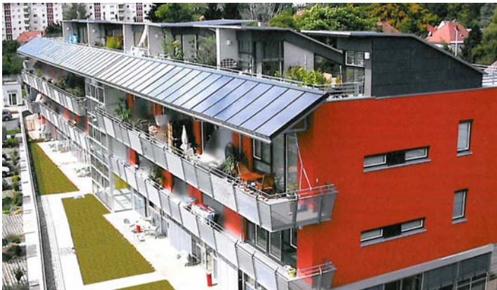
Verschattung durch Balkone und eine Solaranlage
